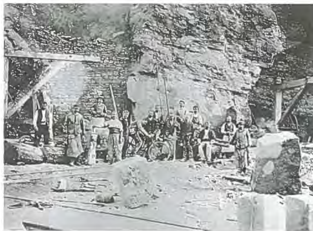
Photo communiquée par la famille Dessainjean. Vers 1910 J. Dessainjean est à droite et son fils sur la bicyclette. On peut voir deux grues qui servait à remonter les blocs du trou, les rails Decauville et le wagonnet.
