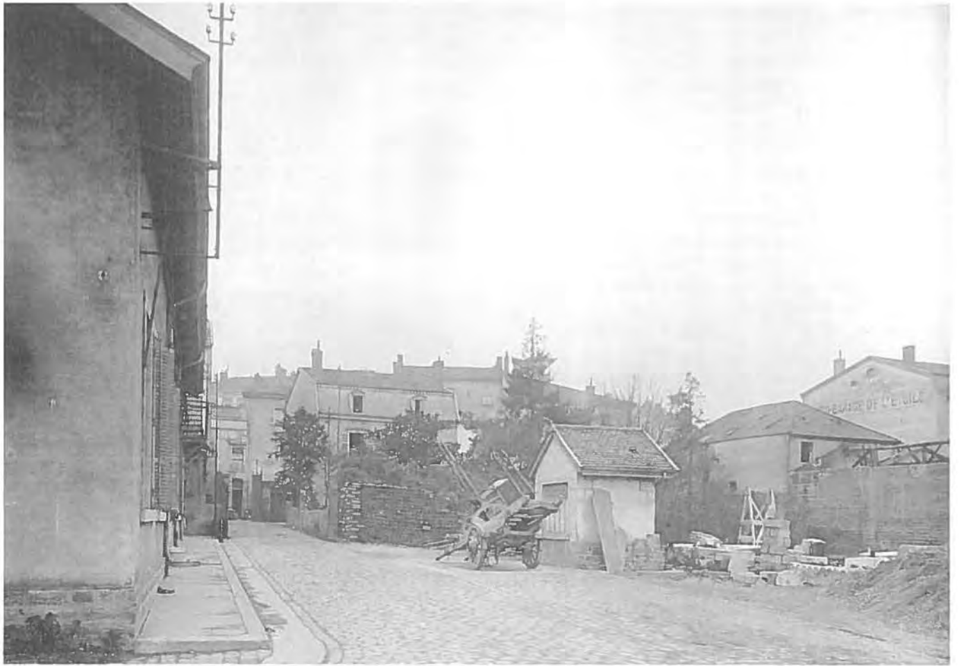
En 1924, la partie sud de la rue de la Paix
