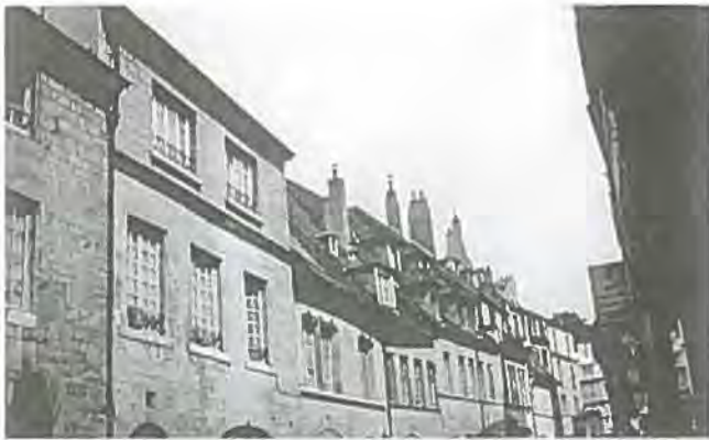
Photo de la Grande-Rue de Besançon. Essayons d'imaginer "l'objet" qui touchait quasi les maisons et éclairait les rues voisines...
